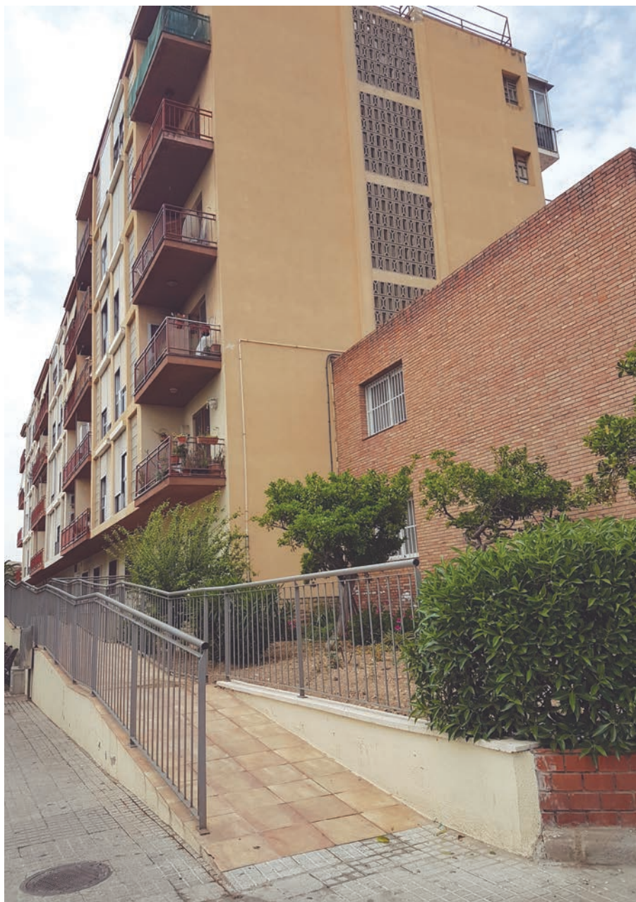
Al Carrer Sant Benilde de Torreforta només s'han pogut fer els accessos adaptats a la part exterior de l'edifici.
