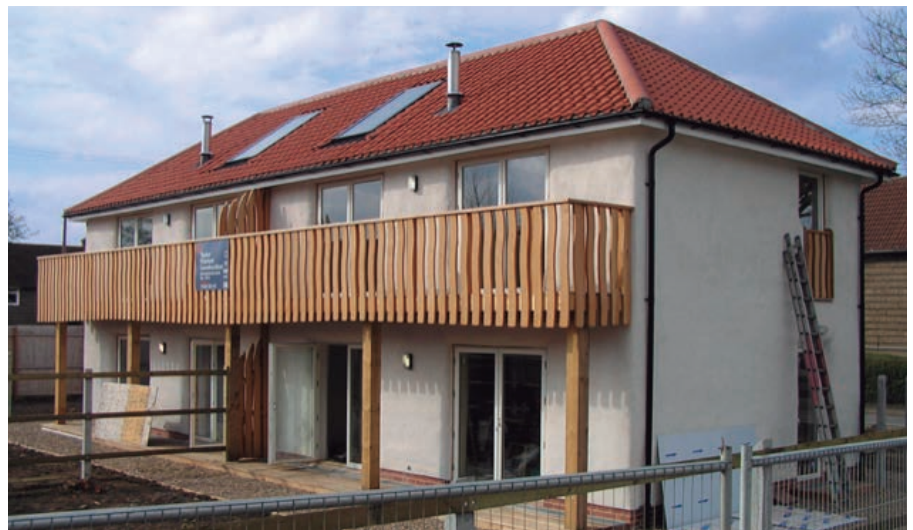
Al Regne Unit fa anys que aposten per la construcció en palla. Aquesta casa està construïda per Straw Works.
