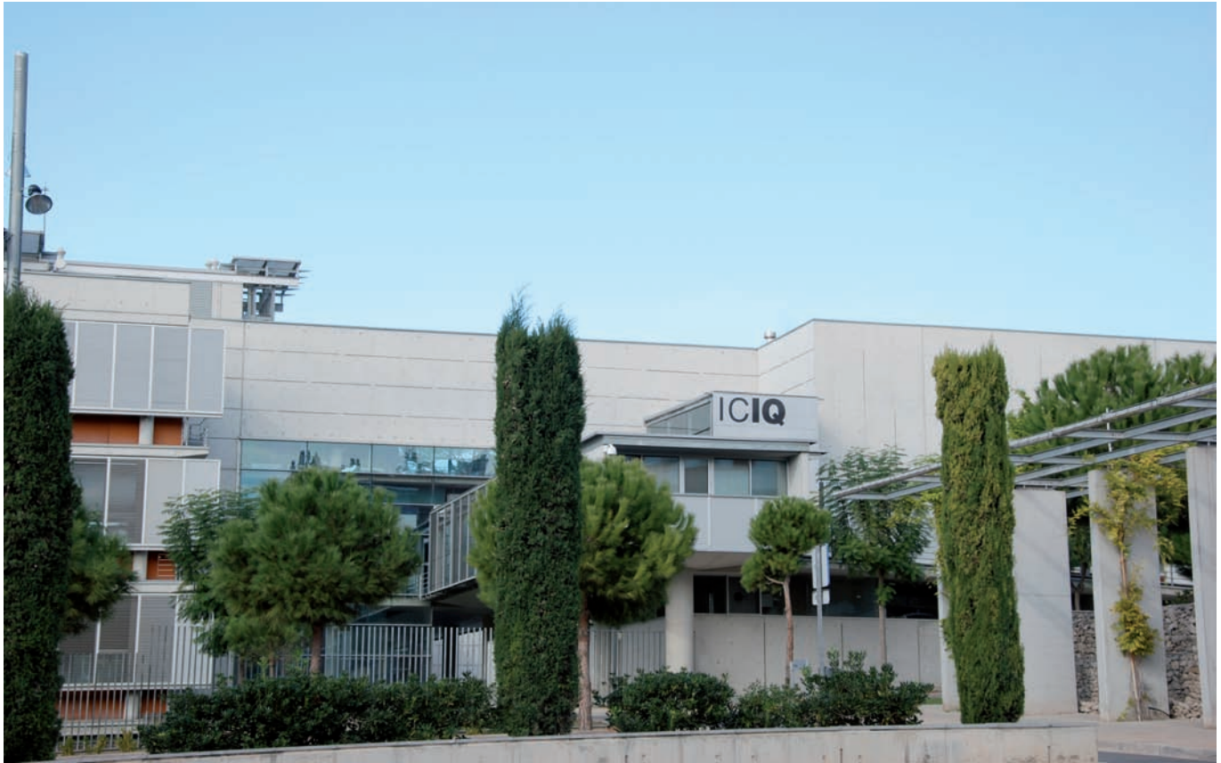
A l'entorn de les facultats de la URV i el seu Campus Sescelades, s'han instal·lat diversos centres. A la fotografia, l'Institut Català d'Investigació Química
