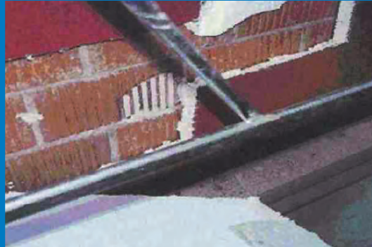
Figura 7: Resultat d'una aplicació per punts de l'adhesiu
