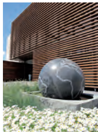
ETAP (Estació de tractament d'aigua potable) a l'Ampolla
