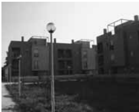
Figura 3. Barri de Barco. Blocs en el pati.
