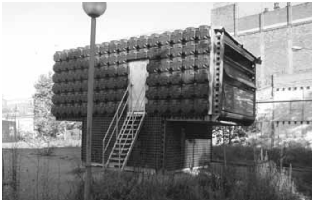
Prototipus econòmic d'habitatge mínim i estructura desmuntable.
