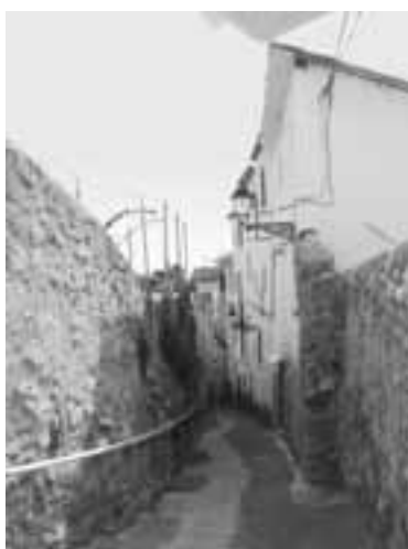
El nucli antic de Berga pateix un important deteriorament físic.
