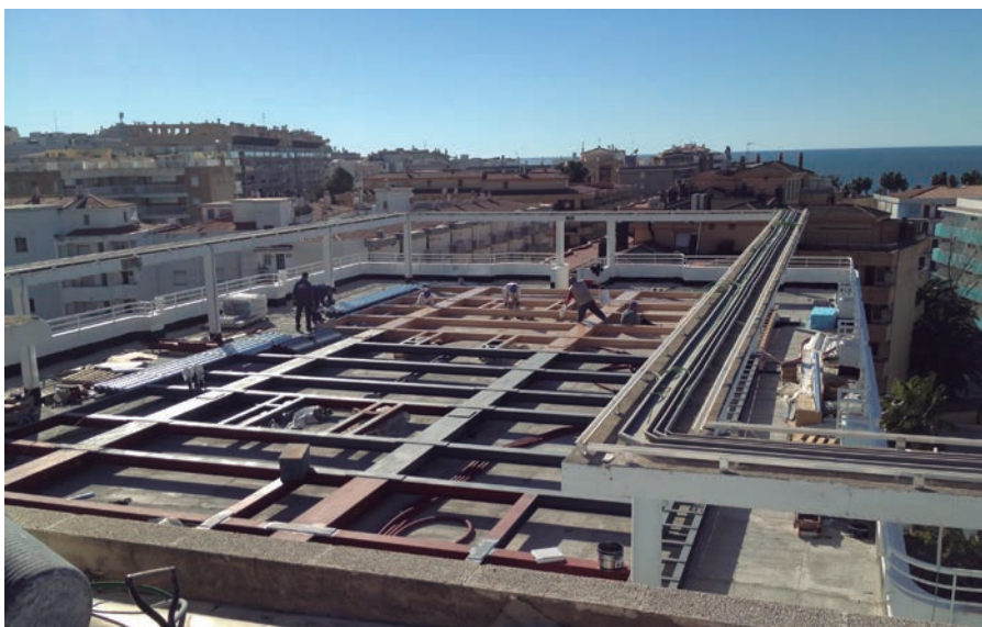
Estructura principal prèvia a la construcció de l'espai aquàtic
