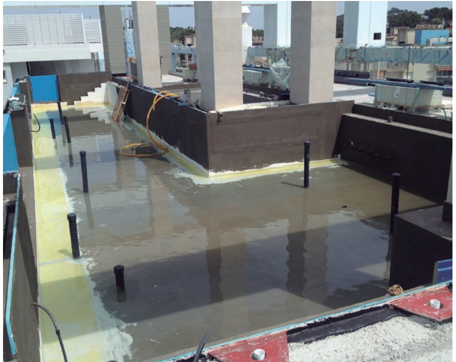
Un dels moments de la construcció de la piscina
