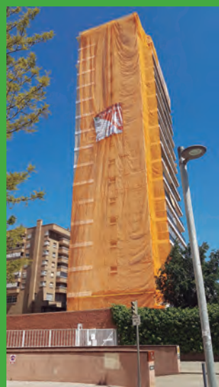
Imagen de un edificio de Tarragona en plena restauración
