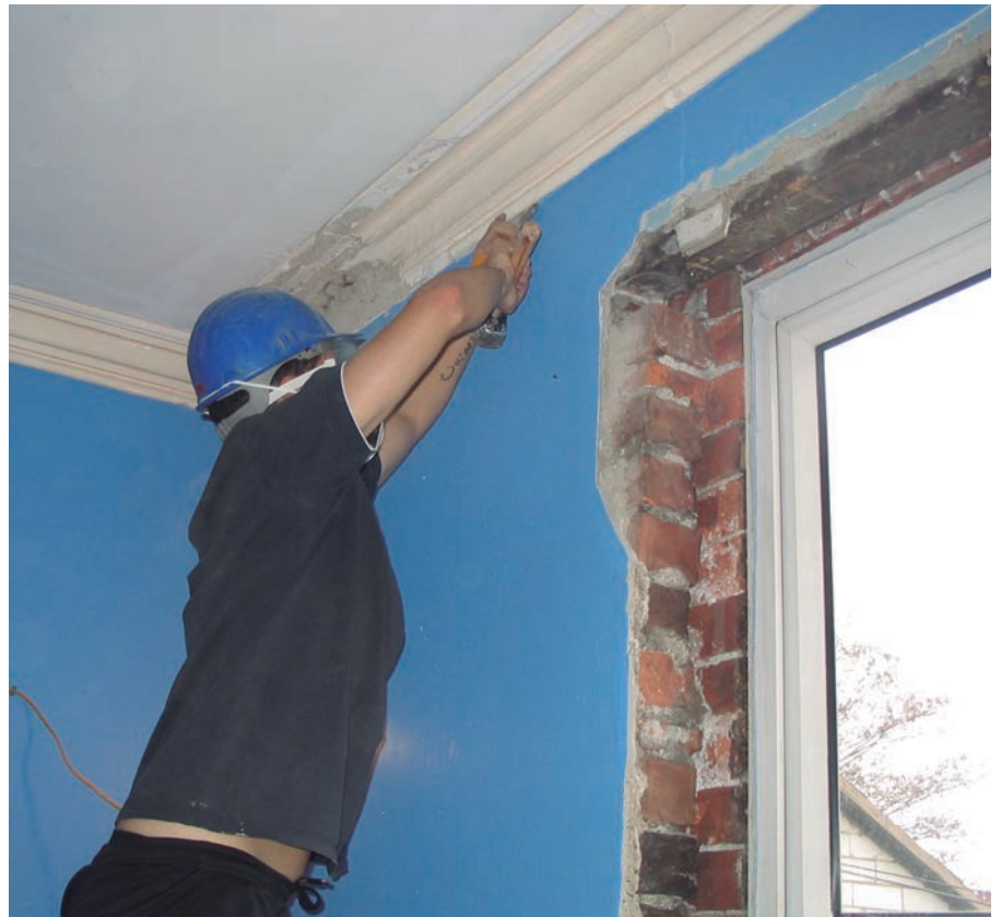
Amb la masoveria, el llogater paga la seva estada amb obres i reparacions
