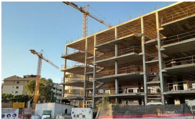
Imatge d'un bloc en construcció a Cambrils | Cedida
