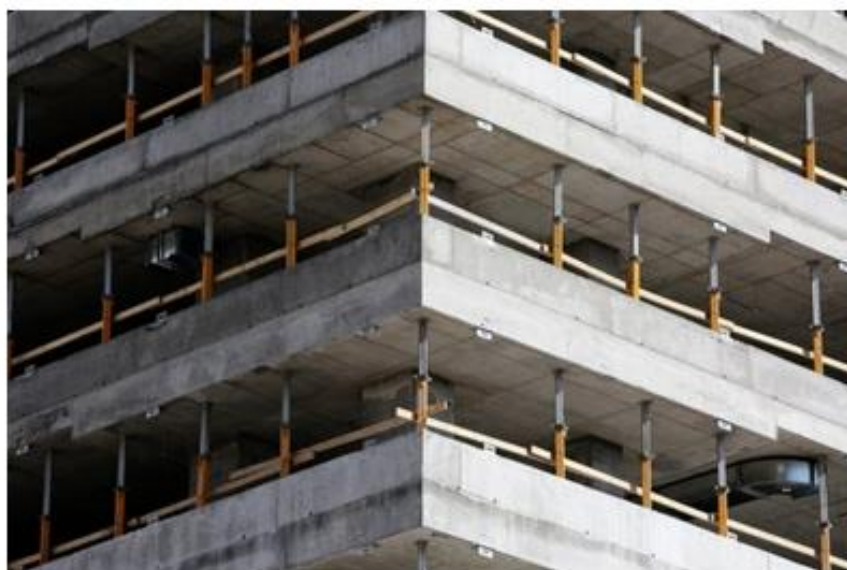
Imatge d'un edifici en construcció
