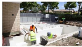
Cherxa construyéndose una piscina en l'Armetlla que, Foto: Luis Sáenz
