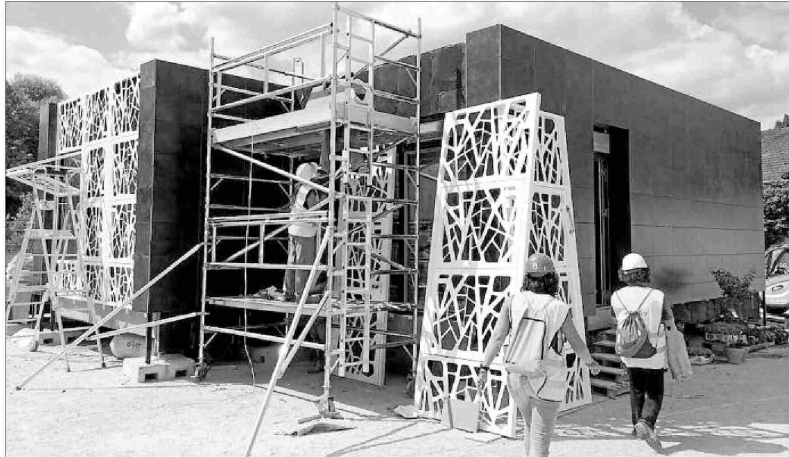
Construcción del prototipo en Versailles. ÉQUIPE VIA-UJI
